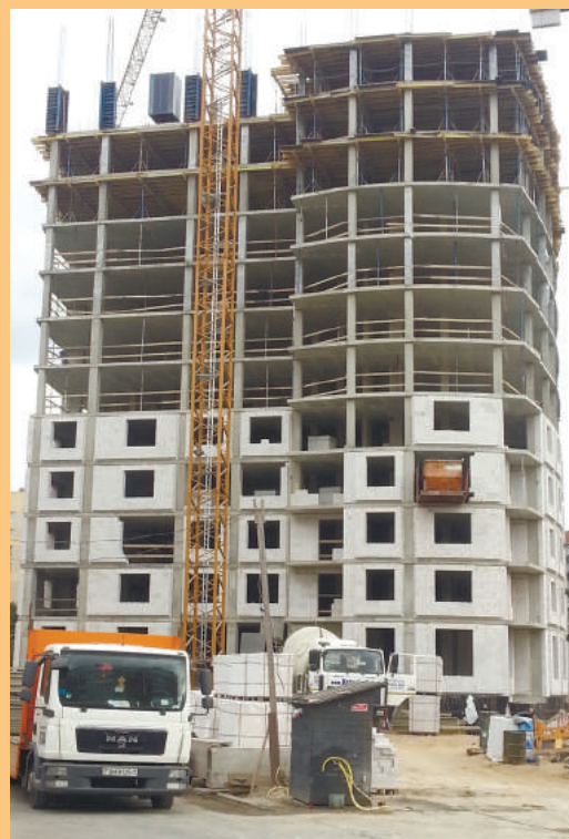
Строительство жилого дома на Сморговском тракте, застройщик компания «Айрон»
